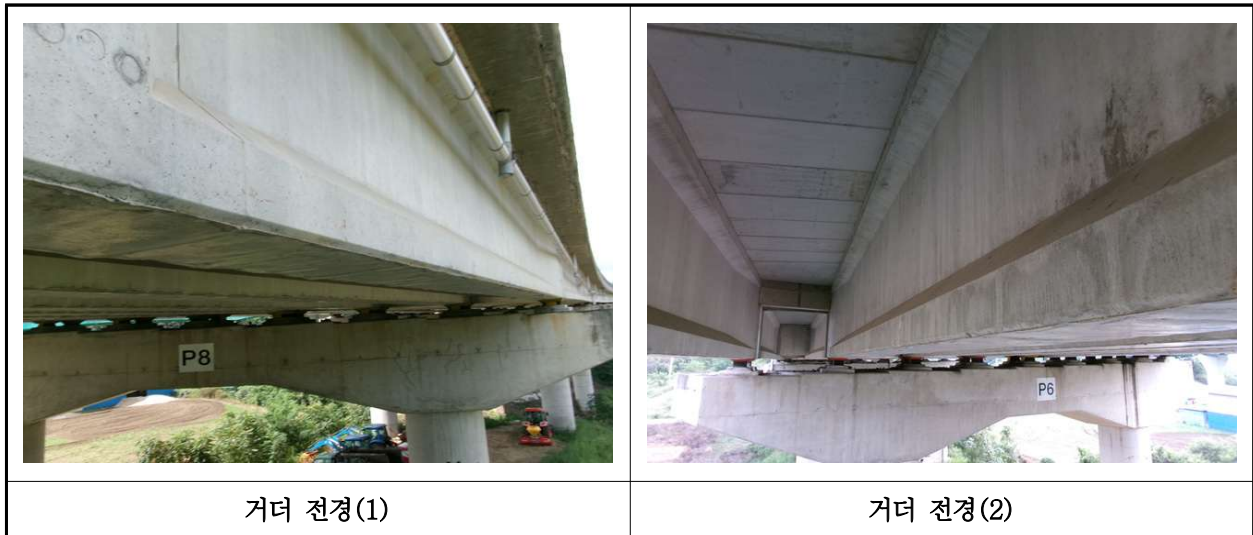
【사진 24.3.4】 거더 전경
