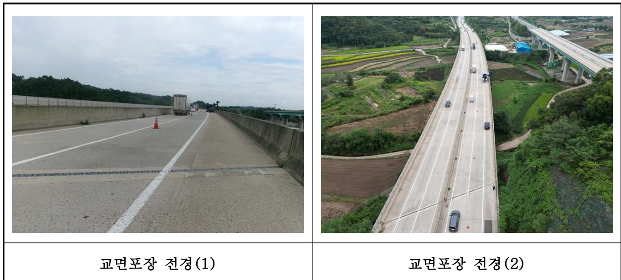
【사진 24.3.20】 교면포장 전경
