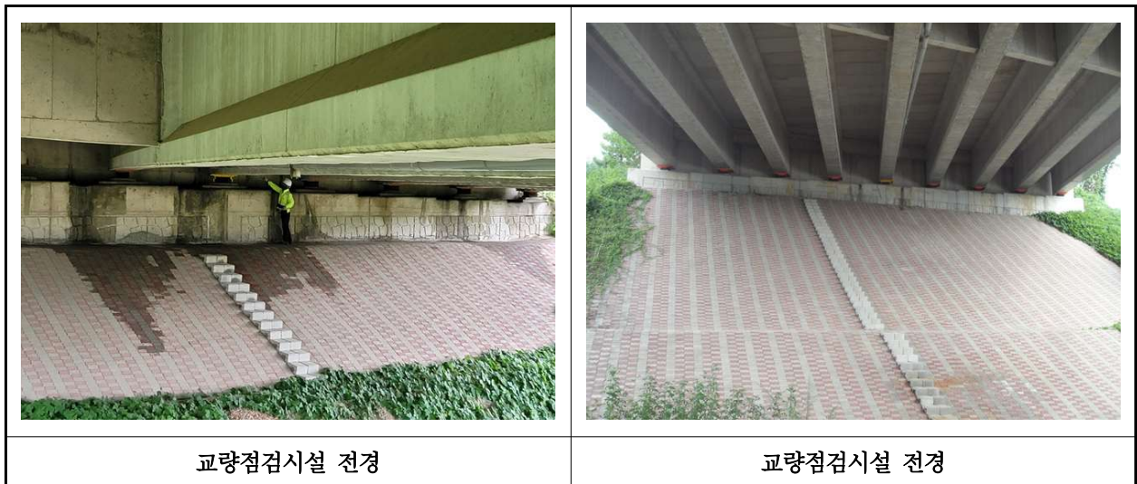
【사진 24.3.26】 교량 점검시설 전경
