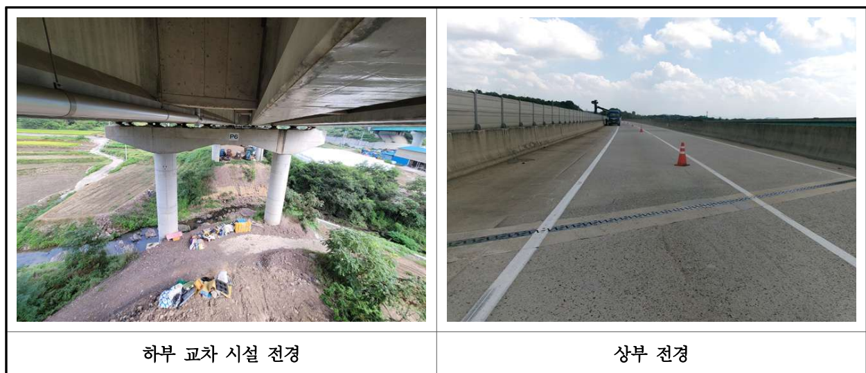
【사진 24.2.1】 부재 현장측정 전경
