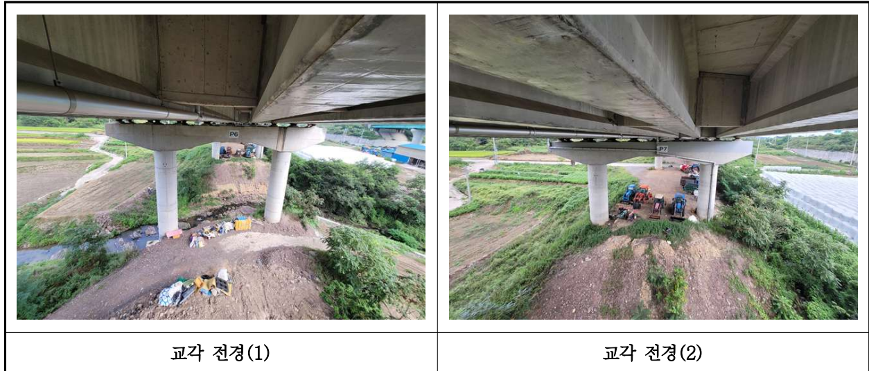
【사진 24.3.10】 교각 전경
