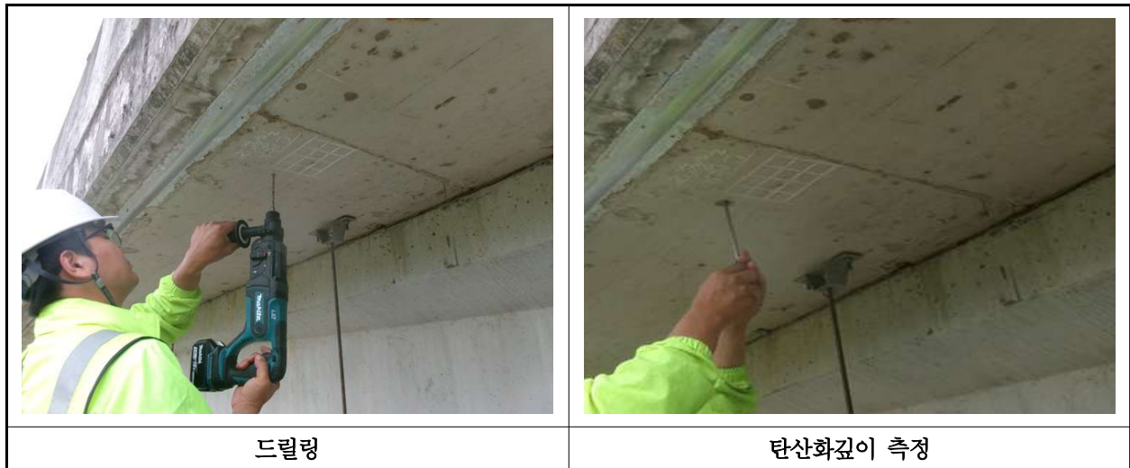
【사진 24.4.3】 탄산화 깊이 측정 현장사진
