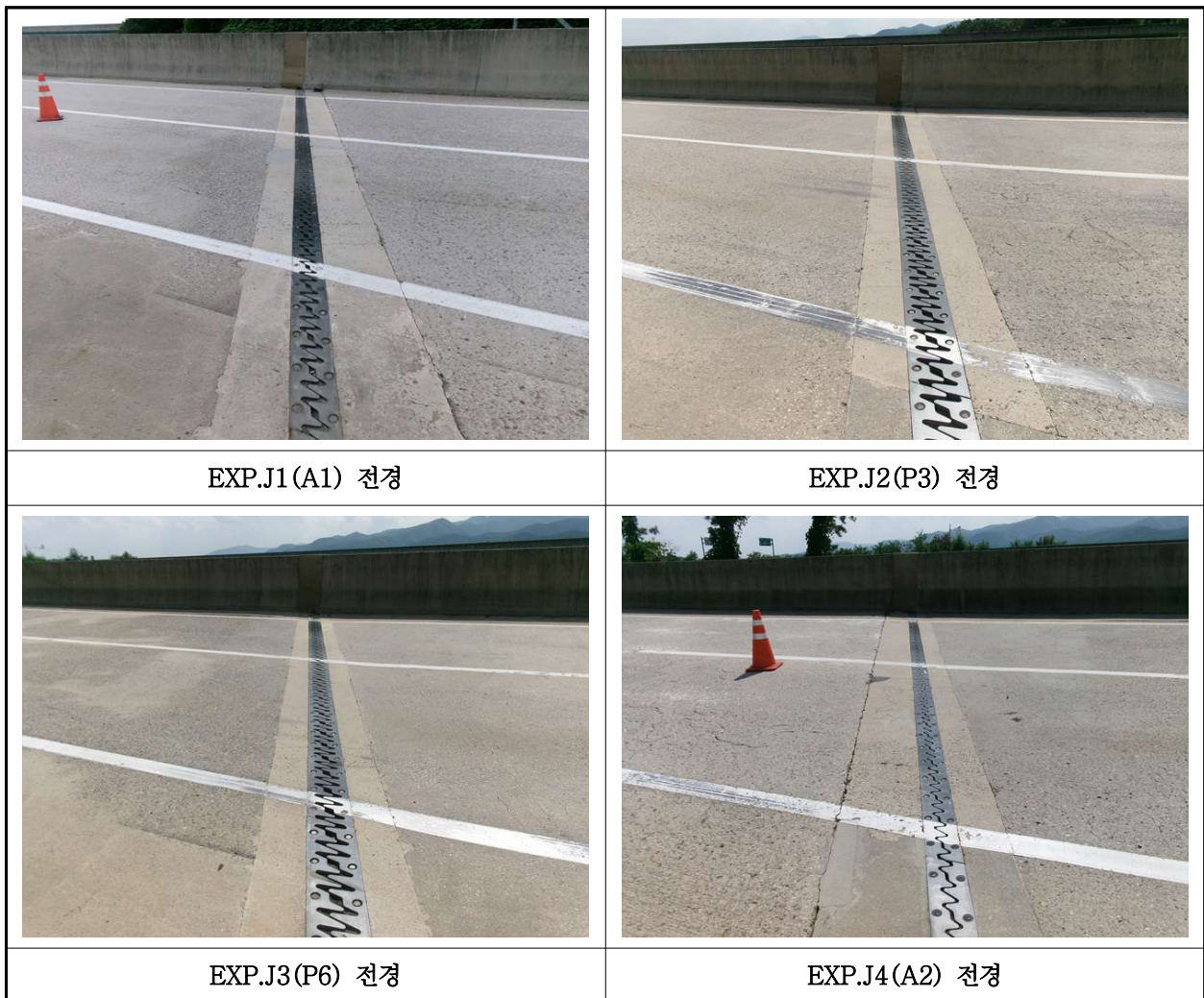
【사진 24.3.17】 신축이음장치 전경
