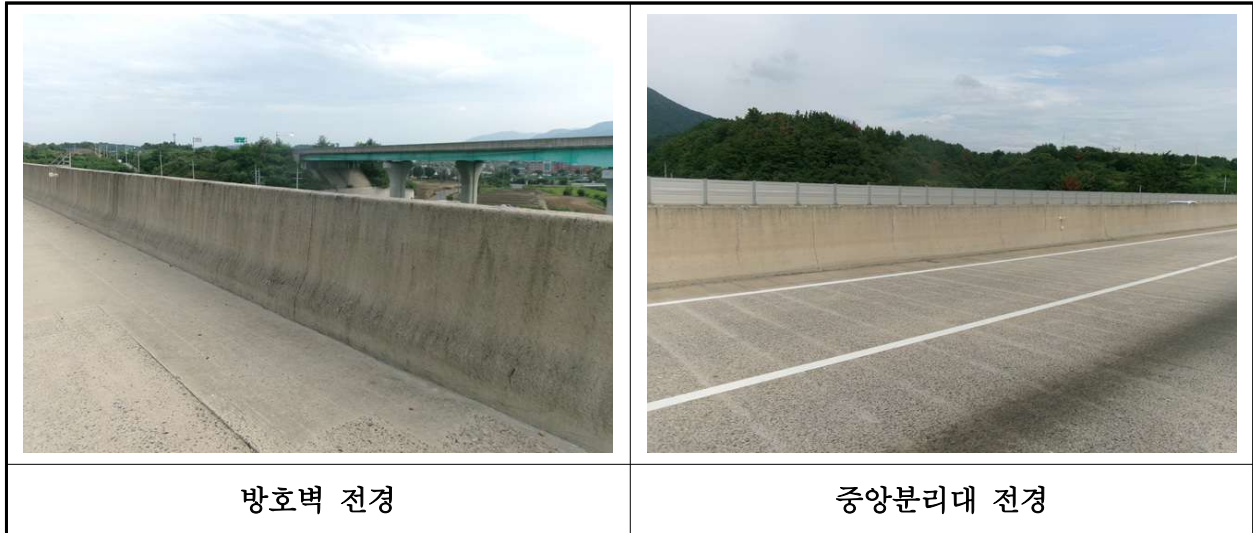
【사진 24.3.24】 방호벽 및 중앙분리대 전경
