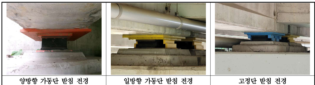
【사진 24.3.13】 교량받침 전경
