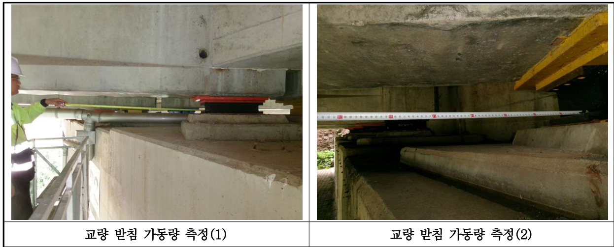
【사진 24.3.16】 교량받침 이동량 측정
