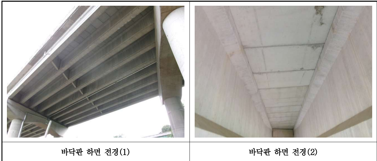
【사진 24.3.2】 바닥판하면 전경
