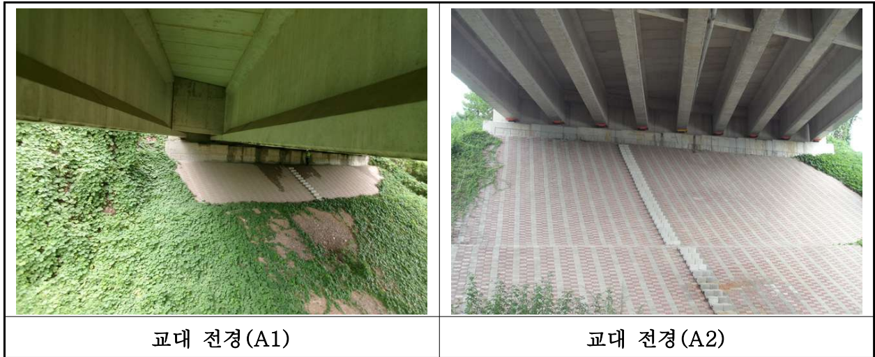
【사진 24.3.8】 교대 전경
