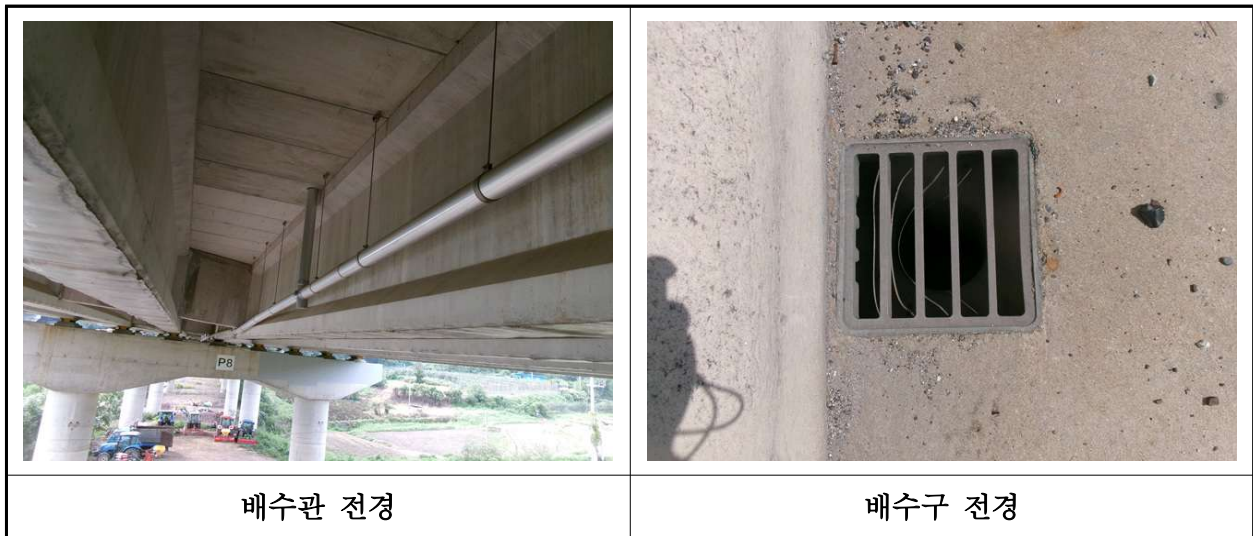
【사진 24.3.22】 배수시설 전경
