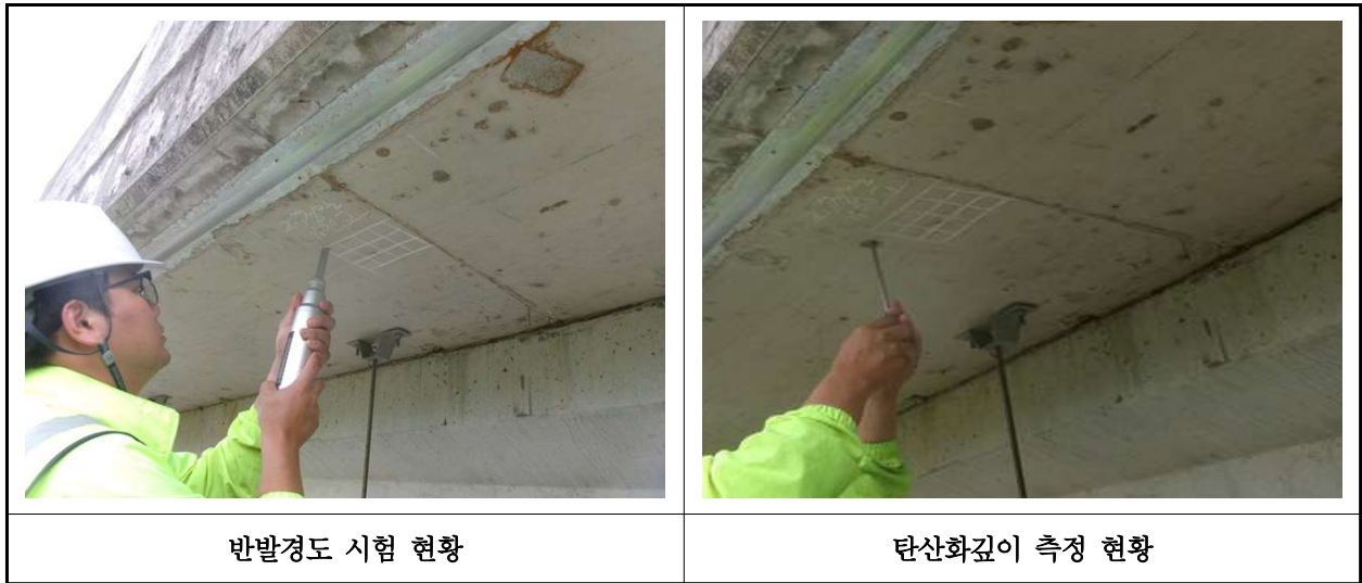
【사진 24.4.1】 콘크리트 내구성조사 현황
