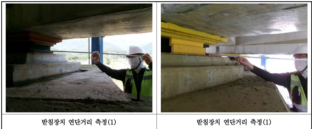
【사진 24.3.15】 교량받침장치 연단거리측정
